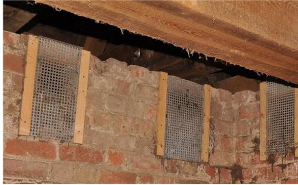
Abb. 9: Nischengitter hinter Maueröffnungen
